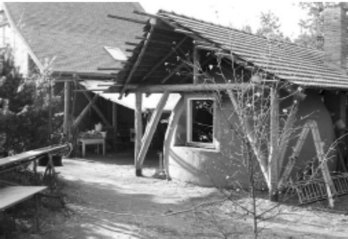
Strohballen-Bau im Club99 (Ökodorf Sieben Linden)
